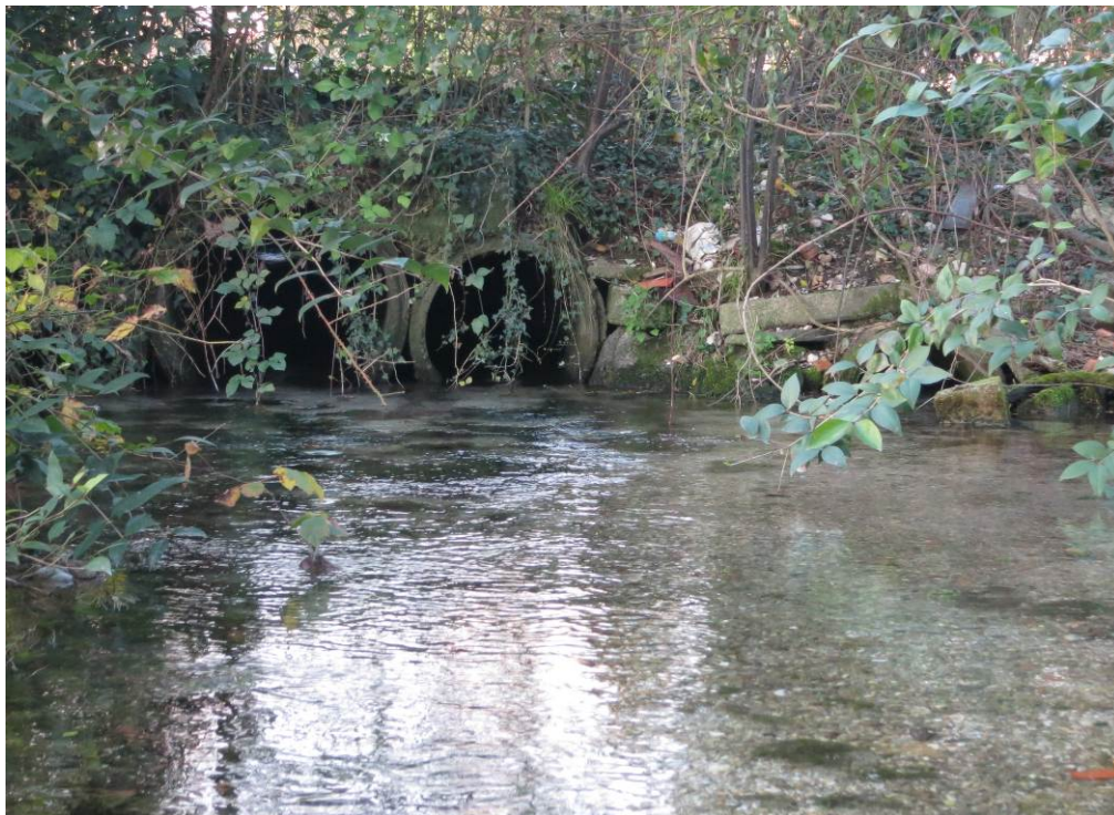
Figura 8: fuoriuscita di acque di risorgiva da un canale tombato (parco di via G. Garibaldi).
